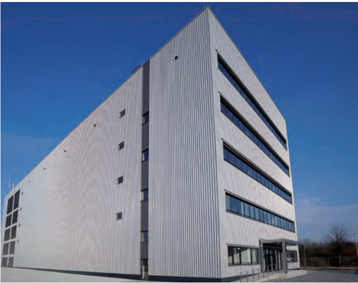
BT Data Center Frankfurt-Sossenheim
